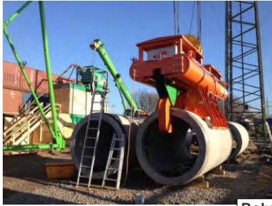
Rohrvortrieb
