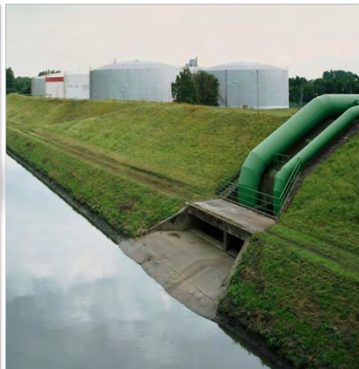
Bachpumpwerke und Düker
