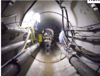
Rohrvortrieb
