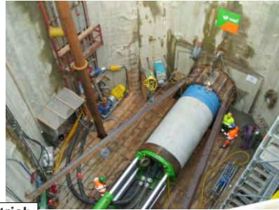
Rohrvortrieb
